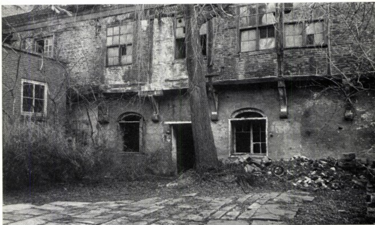
In de Beyarttuin: Noordmuur kapel vrm. klooster der Cellebroeders ( \pm 1530) vóór de restauratie (1962). (foto: archief Beyart)
